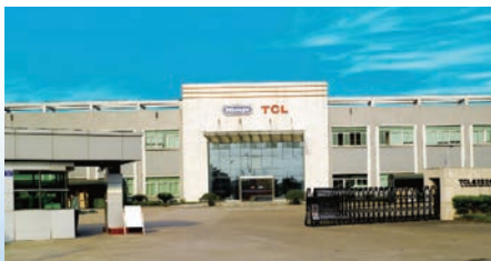
TCL De'longhi JV (1 εκ. φορτία κλιματιστικά & αφυγραντήρες)
